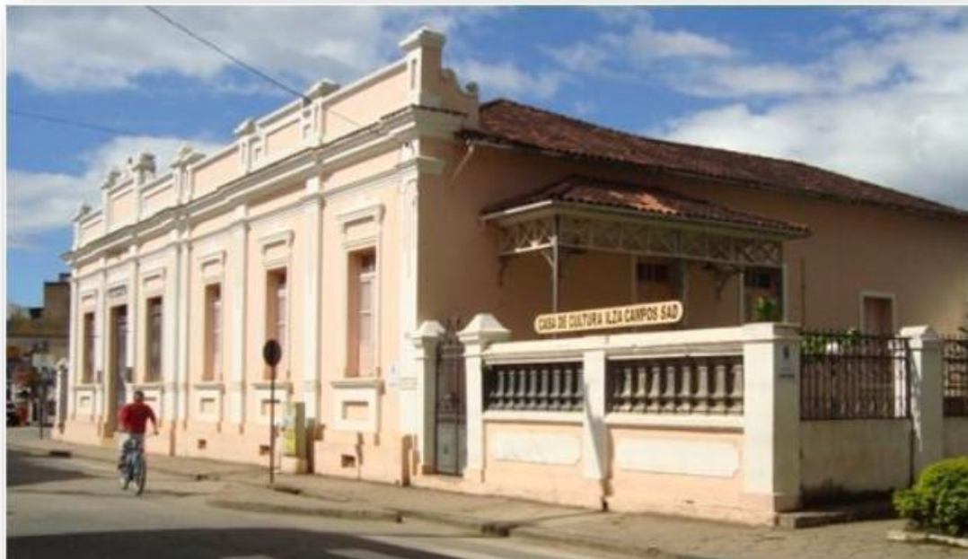
Figura 13: Casa de Cultura de Manhuaçu.
